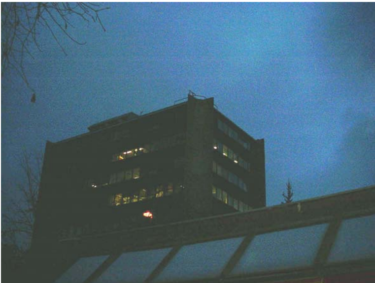
Fotografija 1. Stavba GURS, kjer naj se nahaja bazna postaja za mobilno telefonijo. Spredaj streha vrtca.
