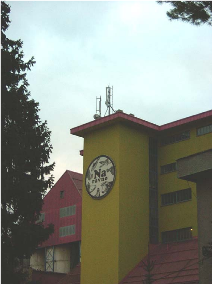
Sliki 3a in b. Stolpi bazne postaje za mobilno telefonijo na stavbi Jata Emona, Kavčičeva 72.
